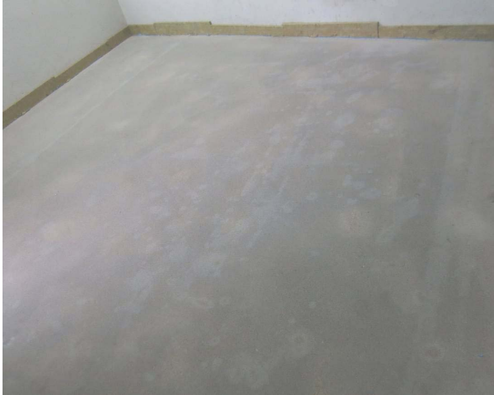
Abbildung A 2.3: fertiggestellter Zementestrich (Prüfsituation)
