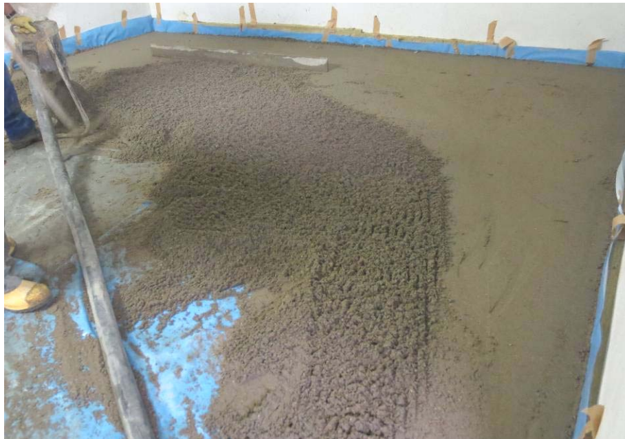
Abbildung A 2.2: Montagesituation mit Zementestrich
