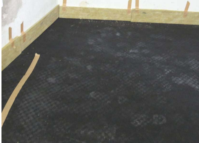
Abbildung A 2.1: Montagesituation Trittschalldämmbahn und Randdämmstreifen
